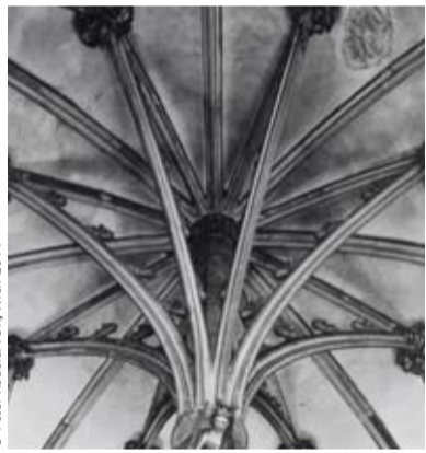
Gewölbe der Katharinenkapelle im Südturm, 1965–1970
